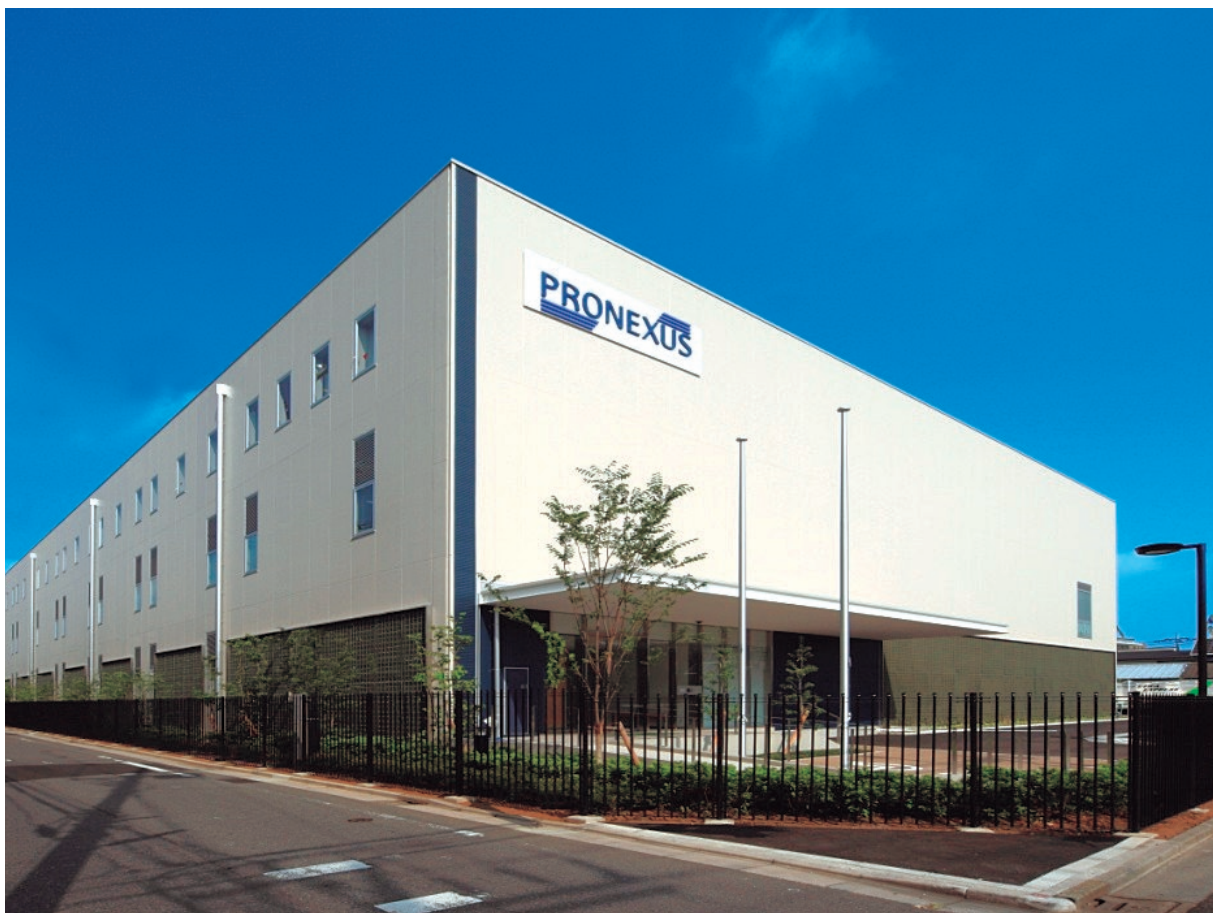
(株) プロネクス戸田工場（外壁）
