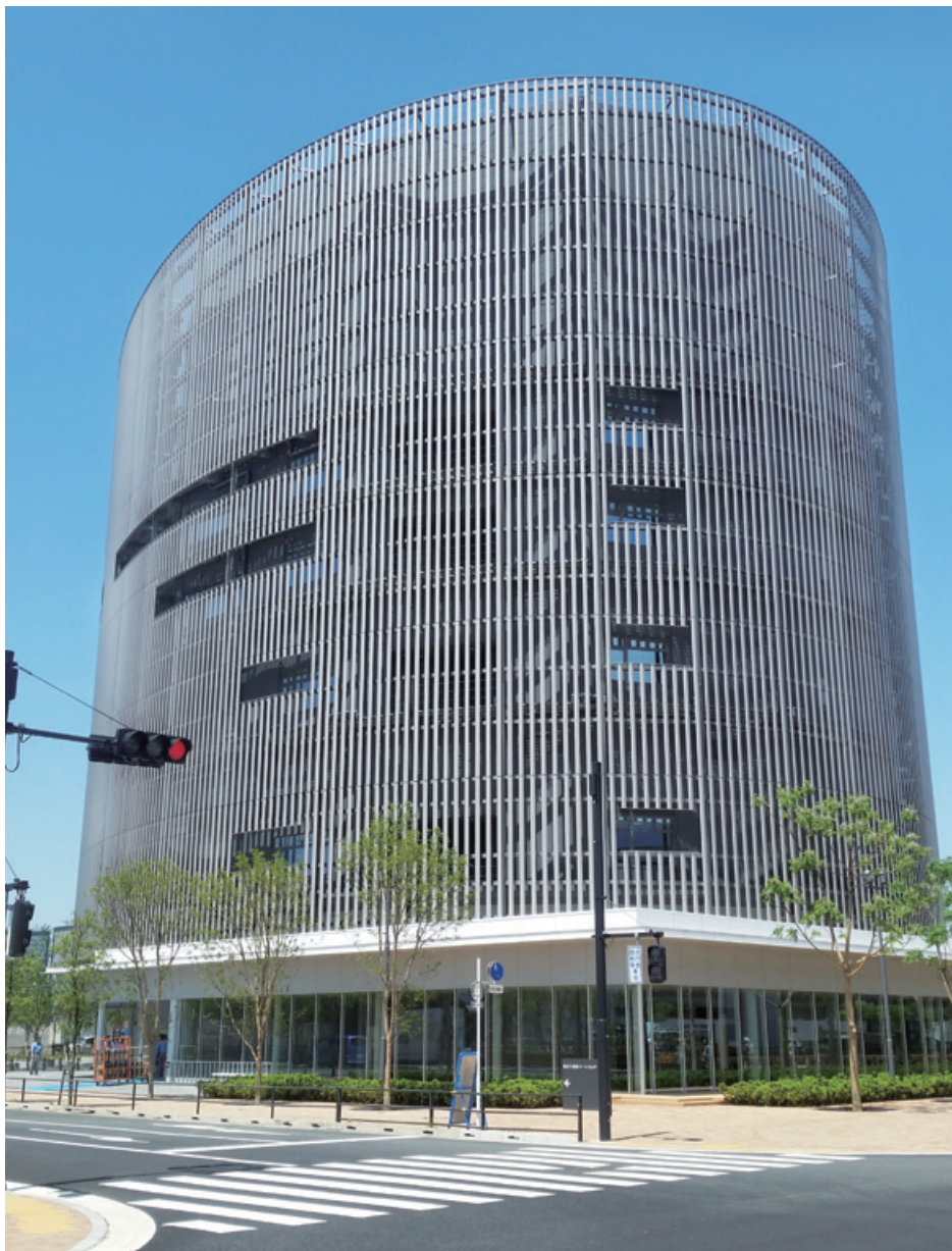
円筒形モチーフのプラント関連施設外壁に採用
