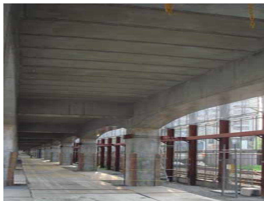
中央線高架化工事 (三鷹～立川間)
