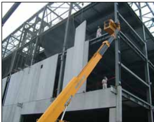
現在の施工状況
