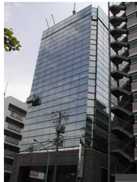
文京区 駒込スパンクリートビル
