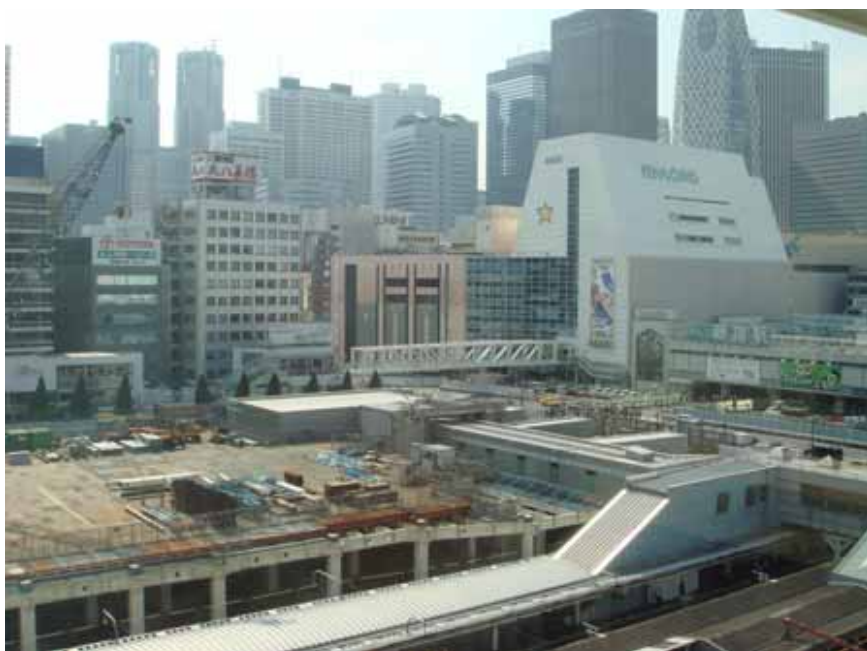
新宿駅南口ターミナル工事
