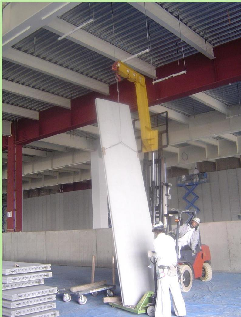
間仕切壁の施工は、ミニクレーン・フォークリフトなどで施工します。
