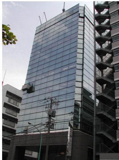
文京区 駒込スパンクリートビル
