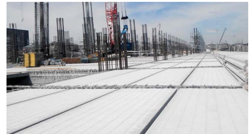
合成床施工写真
