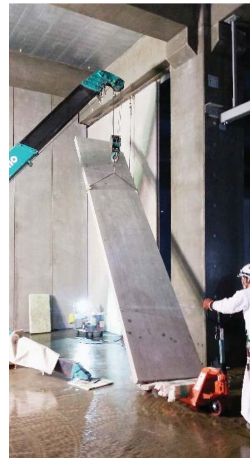
間仕切壁施工写真
